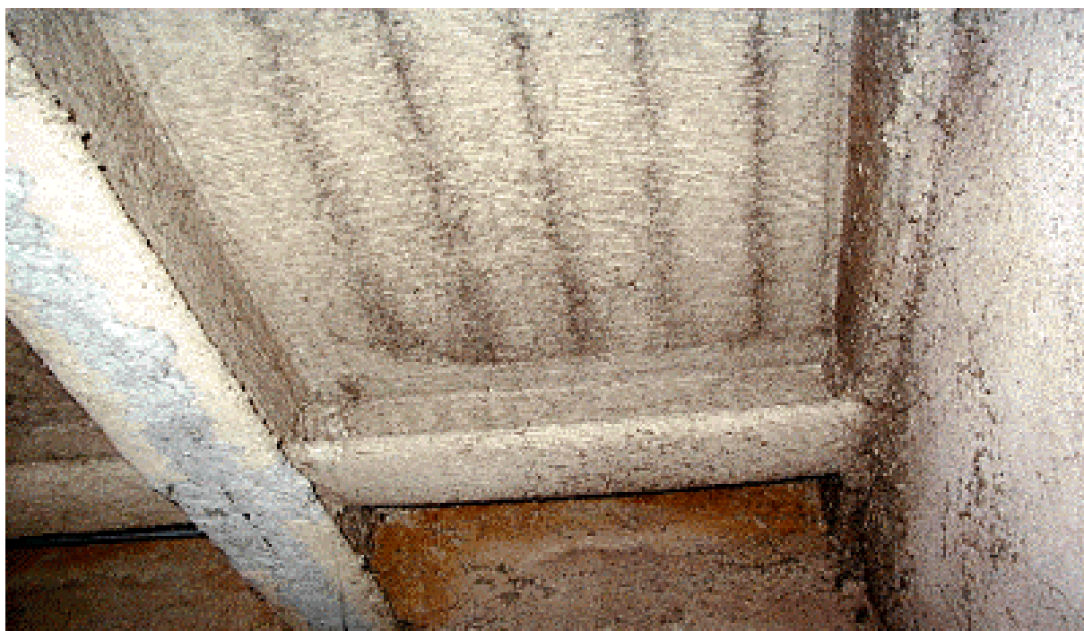
Figura 4. Soffitto e struttura portante in acciaio coibentate con amianto spruzzato
