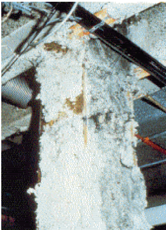
Figura 4. Soffitto e struttura portante in acciaio coibentate con amianto spruzzato
